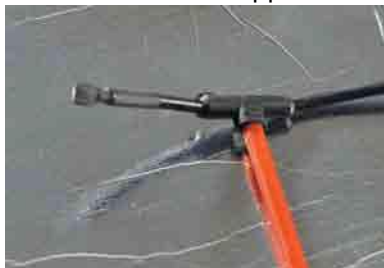
Рис.2. Изоляция начала полосы мата
