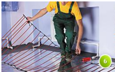
Рис.6. Укладка с одной стороны полосы мата на теплоотражающий материал с последующим разворотом мата
