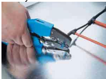
Рис.4. Зажатие гильзы в термоусаживаемой трубке
