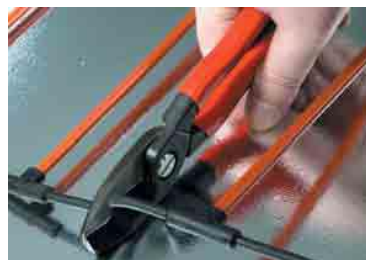
Рис.5. Пример правильного разделения стержневого мата
