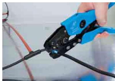
Рис.9. Обжатие клещами трубки на соединительный провод ВВГнг.
