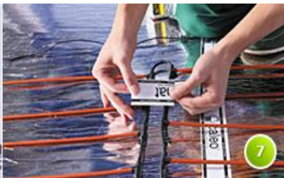
Рис.6. Укладка с одной стороны полосы мата на теплоотражающий материал с последующим разворотом мата
