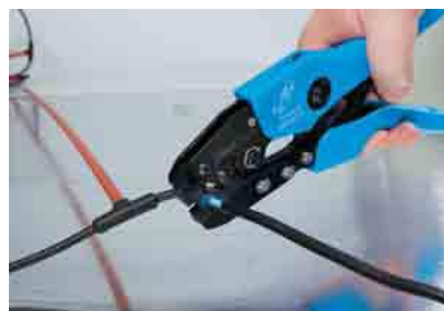
Рис.9. Обжатие клещами трубки на соединительный провод ВВГнг.
