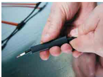
Рис.8. Процесс надевания термоусаживаемой соединительной гильзы
