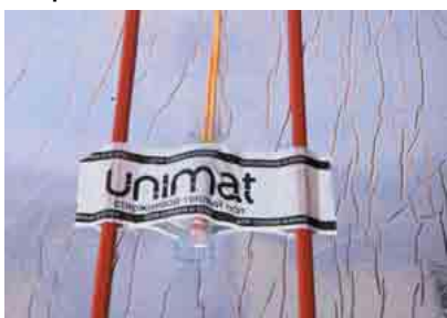
Рис.12. Установка датчика температуры пола между стержнями
