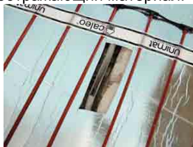
Рис.13. Установка датчика температуры пола между стержнями в гофрированной трубе мата
