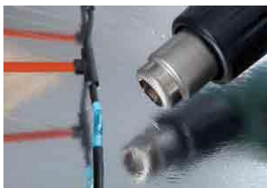
Рис.10. Термоусадка соединительной гильзы техническим феном
